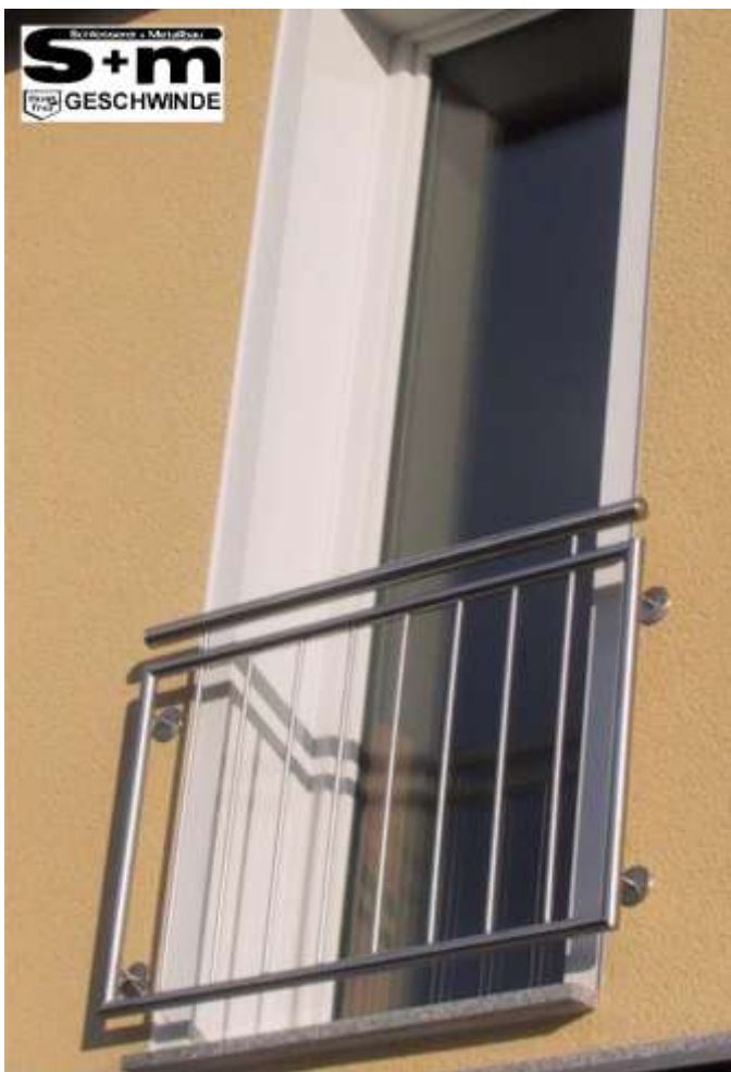
Brüstungsgeländer „Französischer Balkon“ aus Edelstahl geschliffen mit Handlauf und senkrechten Füllstäben
