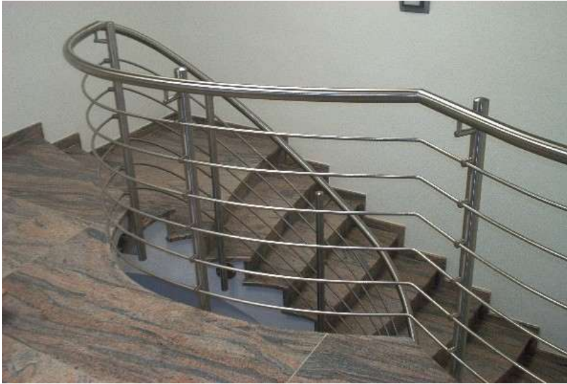
Treppen- und Podestgeländer aus Edelstahl geschliffen mit waagerechten Füllstäben
