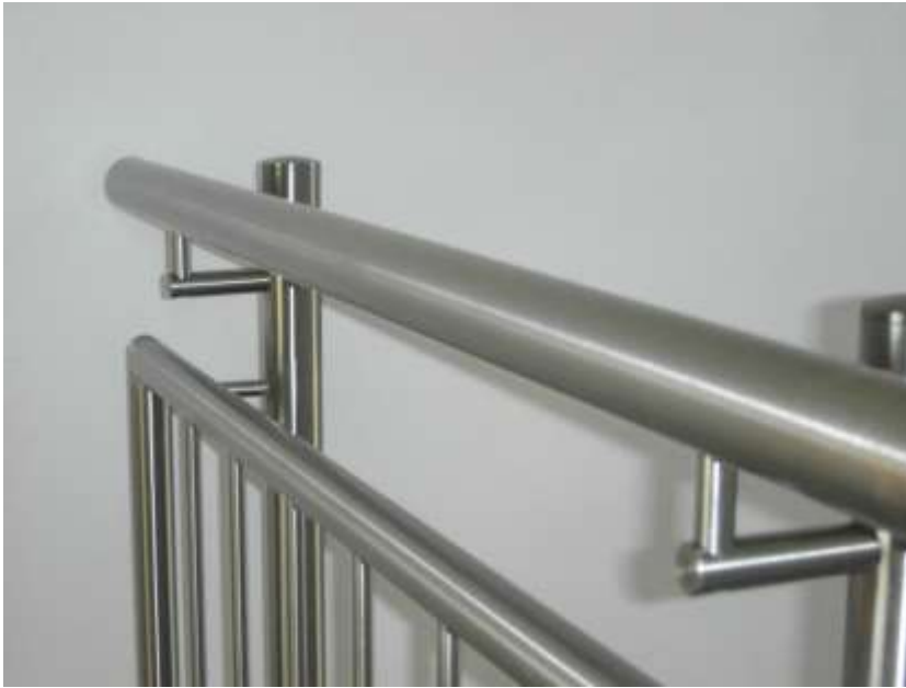
Treppen- und Podestgeländer aus Edelstahl geschliffen
